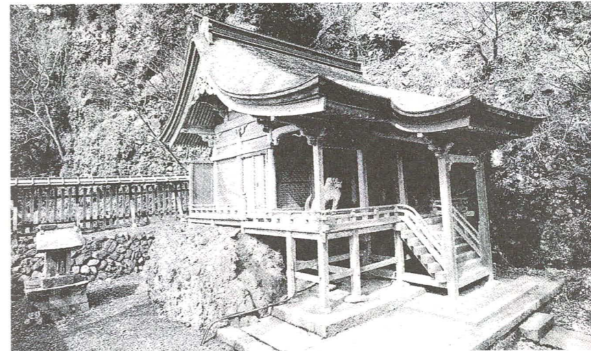
本殿左手前より写す。流造、建物の前に突き出る向拝部がよく分る
